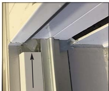
② Profilo di contenimento 76662 a filo del telaio
