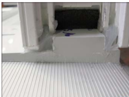
Fig. 2 Sigillatura dopo il montaggio dell'elemento di tenuta centrale.
