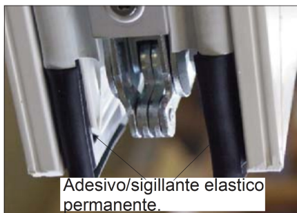
Fig. 2 Installazione del set M430 , sigillando gli angoli.
