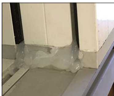
① Adesivo/sigillante elastico permanente sul telaio lato serratura anta A
