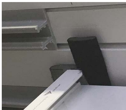
Fig. 2 M589 incollato al telaio a metà tra le guide
